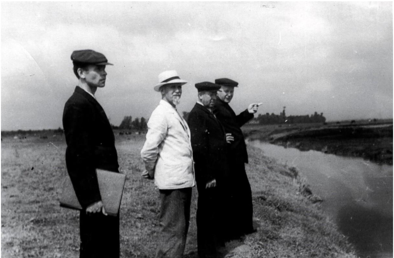
На березі Південного Бугу, справа наліво: голова обкому А. Устенко, голова міськвиконкому Д. Криворучко та міський архітектор В. Соболев обговорюють будівництво водосховища, 1949 р.
