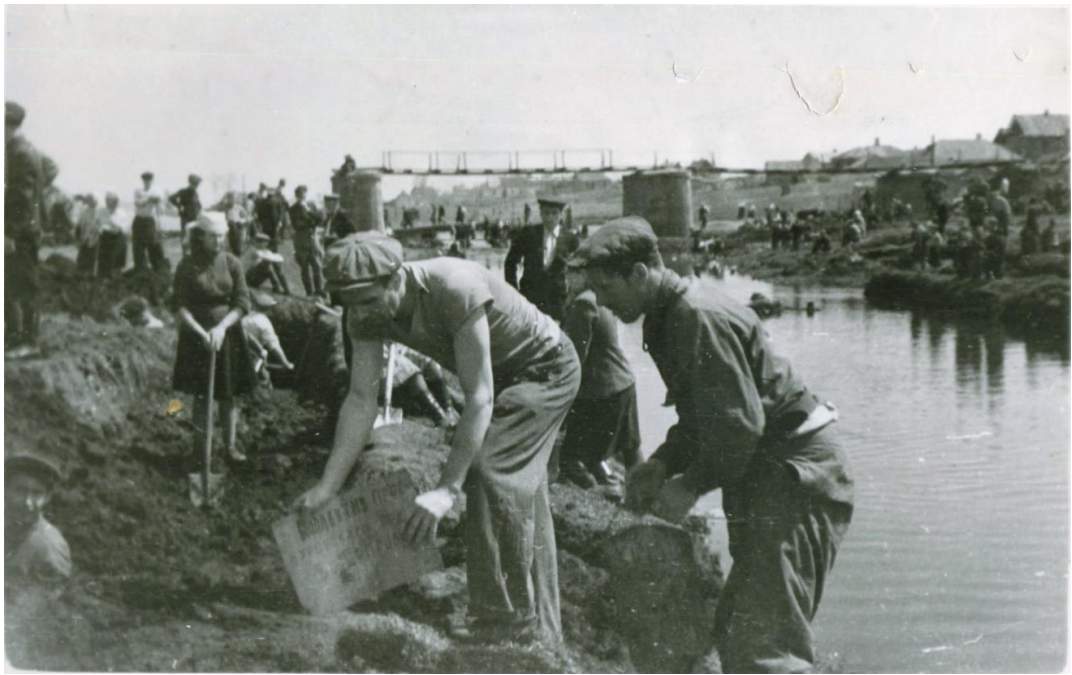
На будівництві водосховища, 1949-50 рр.
