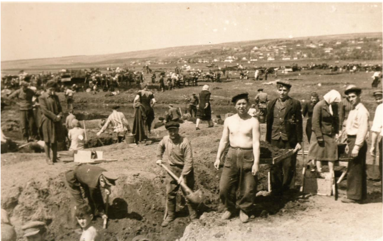
На будівництві водосховища, 1949-50 рр.
