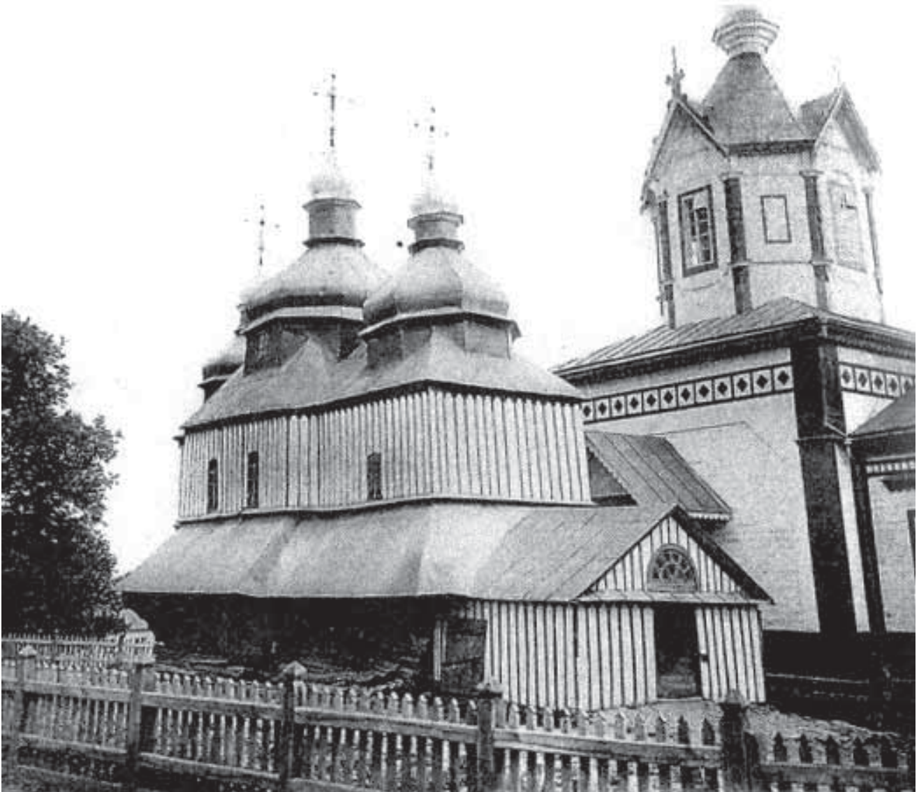
Цегляна будівля Свято-Михайлівської церкви поруч із старою дерев'яною. Фото Є. Сіцинського.
