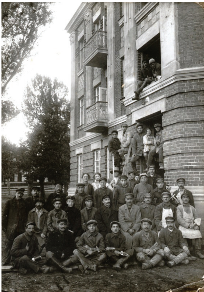
Мал. 2. Будівельники житлового будинку по вул. Р.Люксембург (нині – вул. Грушевського,74). Фото 1928 р.
