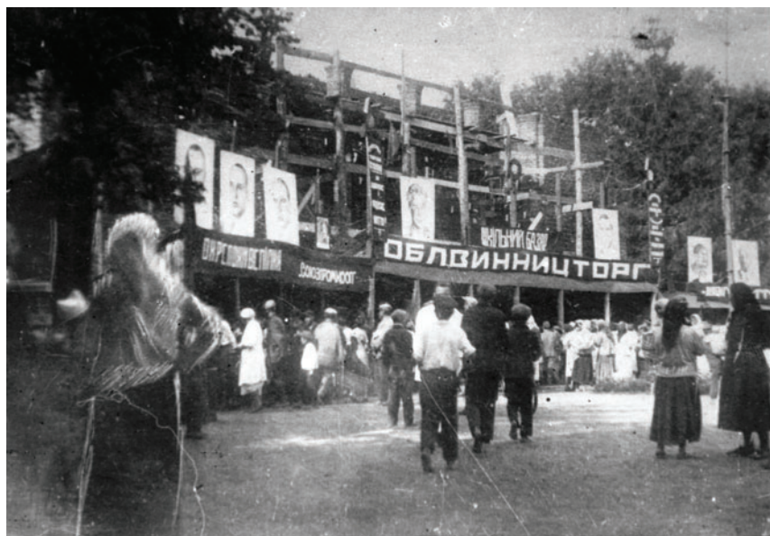
Мал.17. Будівництво кінотеатру. На дальньому плані видно будівельні риштування та збудовані колони. Фото 1937 р.
