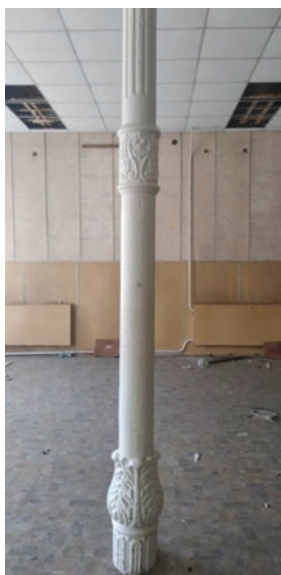
Іл. 3. Підпiрна чавунна колона, виробництва заводу Ашкiназi, кiн. ХІХ ст.
